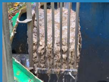
Voilà ce que deviennent les lingettes jetées dans les toilettes.
